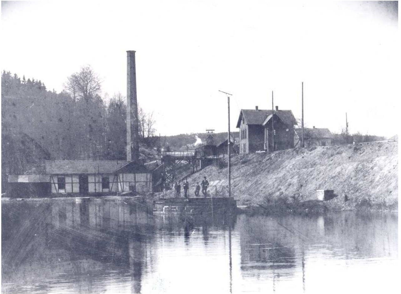
Die Aufnahme aus dem Jahre 1908 zeigt links das 1878/79 errichtete Pumpwerk und im Vordergrund den Sockel des späteren Pumpwerkes, rechts oben, das für die Bahn 1905 erbaute Stationsgebäude.
